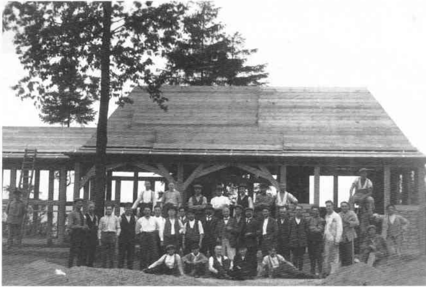
Bauarbeiter und Vereinsangehörige beim Bau des Umkleide- und Gerätehauses
